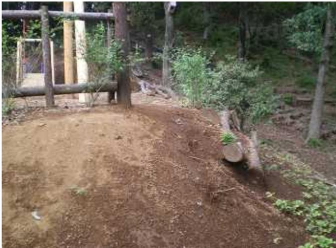
山の一部を削ってフィールドアスレチック。際に「オウバイ」を植栽しましたが、斜面の土が徐々に流れ落ちてしまうため、丸太土留めを付けることにしました。
