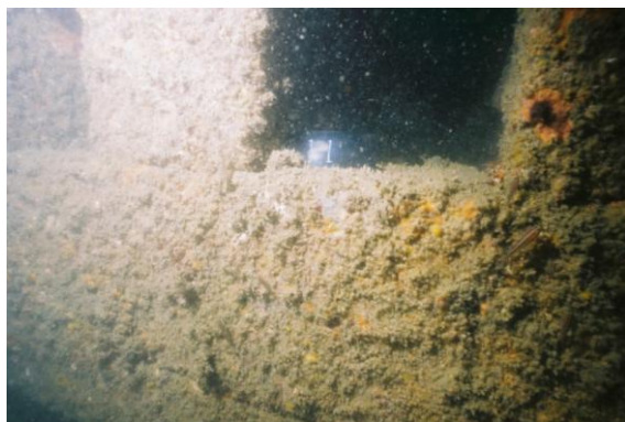
藻礁配合コンクリートの付着生物状況
