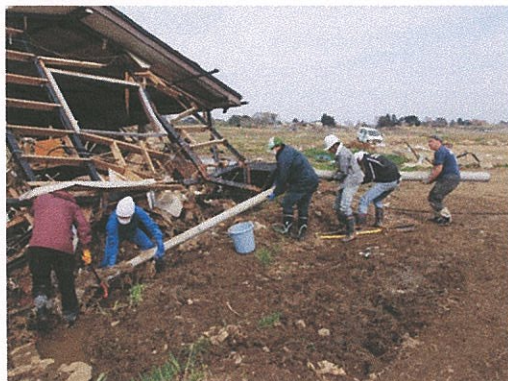
③津波が運びこんだ土砂や石を除去（5月2日～5月4日）
