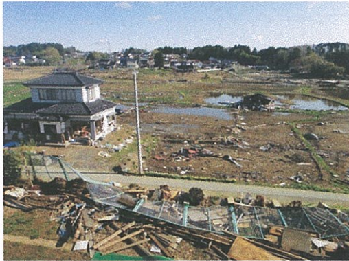
②車など大きな漂着物の撤去、水路をふさぐ家屋の一部解体（4月30日～5月5日）
