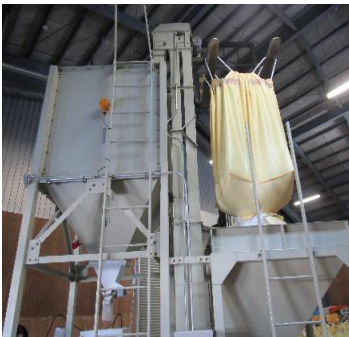
北竜支所を探索していると見慣れない機械を発見！何やらお米の種子が沢山入っているようです(?▽?)
