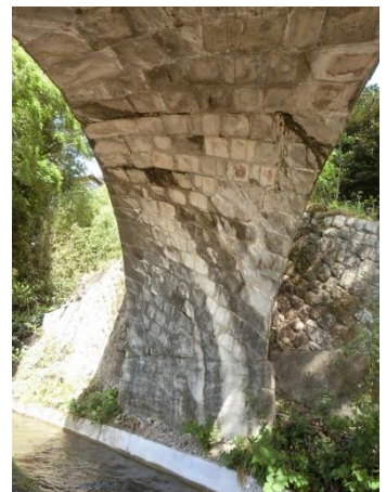
下から見上げたねじり橋
