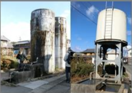
麻生田自噴井
