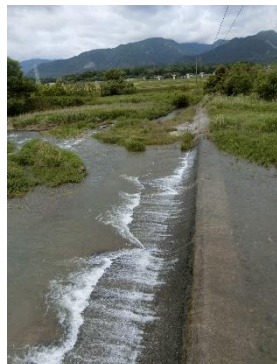
コンクリート堰堤
