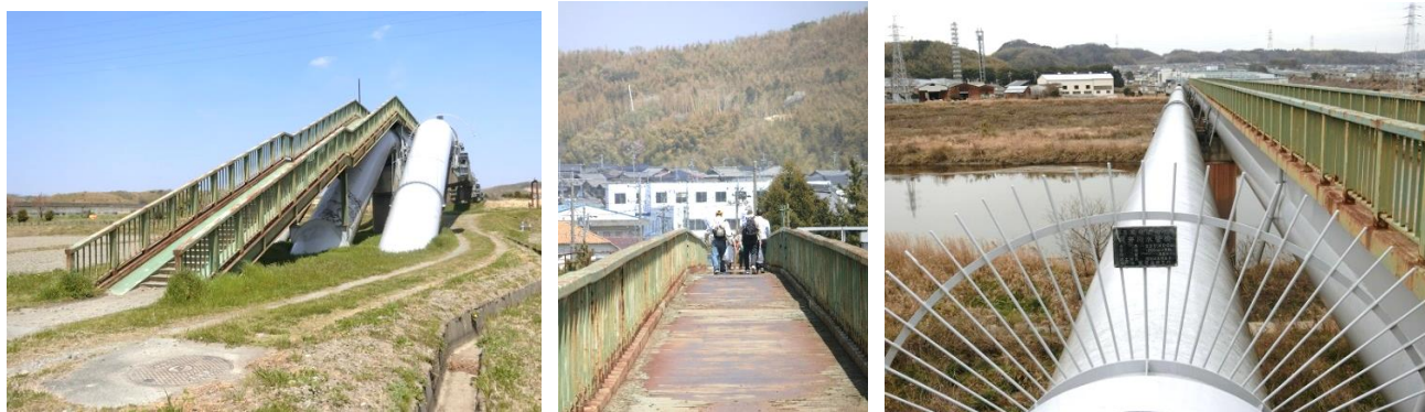
員弁川水管橋
