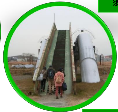
員弁川水管橋
