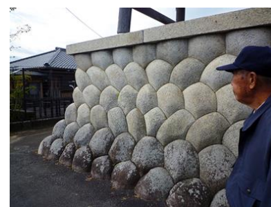
鐘樓の石積み
