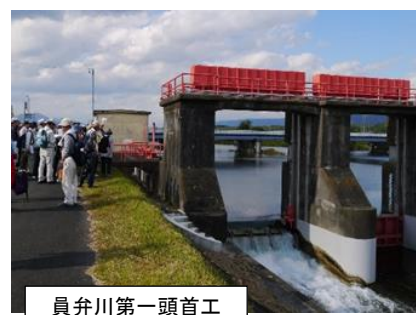
員弁川第一頭首工
