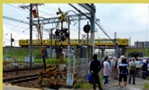
関西線跨線橋・名古屋線跨線橋
