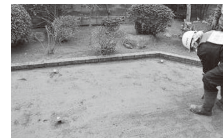
▲除去土壌の地下保管の目印の杭
