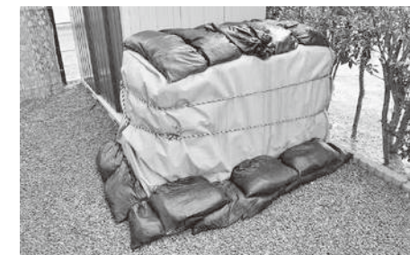
▲除去土壌の地上保管例
