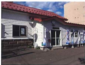
定山溪鉄道の旧石切山駅は、現在、石山振興会館として使われています。 建物の基礎部分には、札幌軟石が使用され、石山商店街振興組合の事務所も併設されています。
